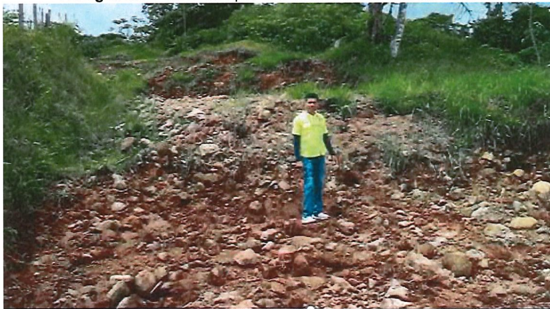
Fotografía 3. Estado del camino, donde se evidencia que no es transitable para vehículos.
