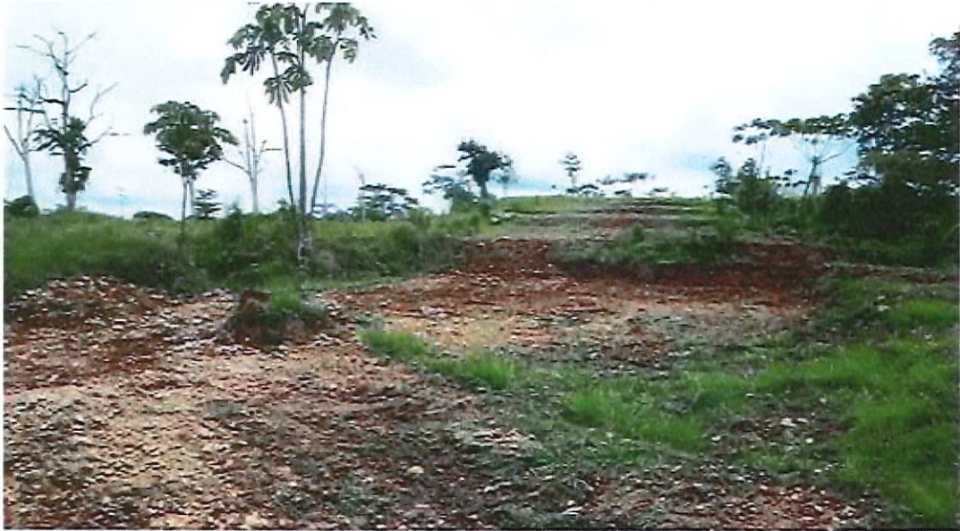
Fotografía 4. Área sin inundar, evidencia de movimiento de tierra
