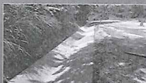
Imagen 6 Construcción de cuneta revestida en Las Colinas
