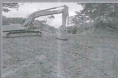
Imagen 11 Reconstrucción de dique La Lucha
