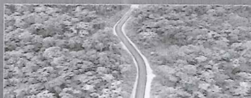
Imagen 5 Mejoramiento con carpeta asfáltica en Tierra Grande
