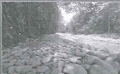
Imagen 10 Reconstrucción de dique Río Dos Novillos
