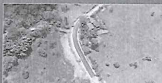
Imagen 7 Construcción de carpeta asfáltica en Las Colinas
