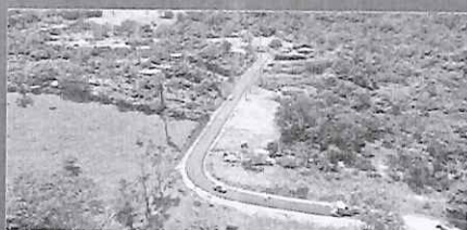
Imagen 4 Mejoramiento de carpeta asfáltica en la Argentina
