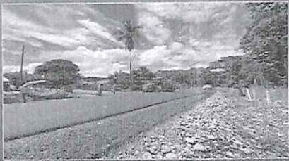
Imagen 3 Mejoramiento con carpeta asfáltica en Mercedes
