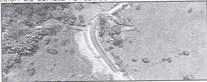
Imagen 7 Construcción de carpeta asfáltica en las Colinas
