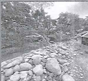
Imagen 13 Reconstrucción de dique Iroquois
