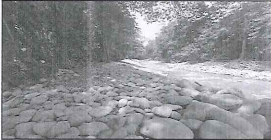
Imagen 10 Reconstrucción de dique Río Dos Novillos Reconstrucción dique La Lucha
