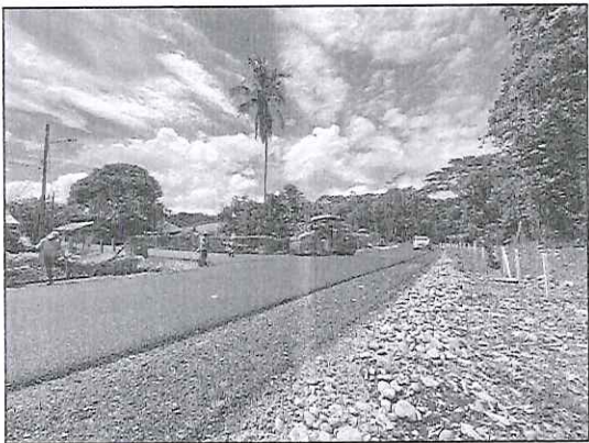
Imagen 3 Mejoramiento con carpeta asfáltica en Mercedes
