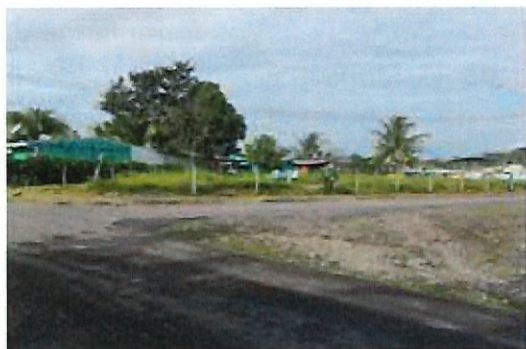
Fotografía 1. Limpieza de área de bancas.
