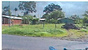
Fotografía N° 4. Vista general del inmueble desde la vía pública, con el material depositado.
