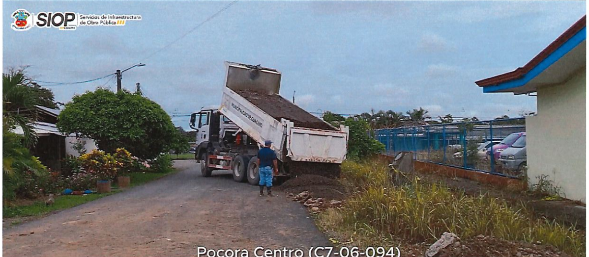
Mejoramiento de los sistemas de drenajes
