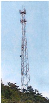
Torres de telecomunicaciones
