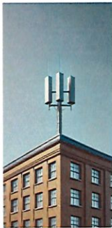
Edificios y/o sus Azoteas
