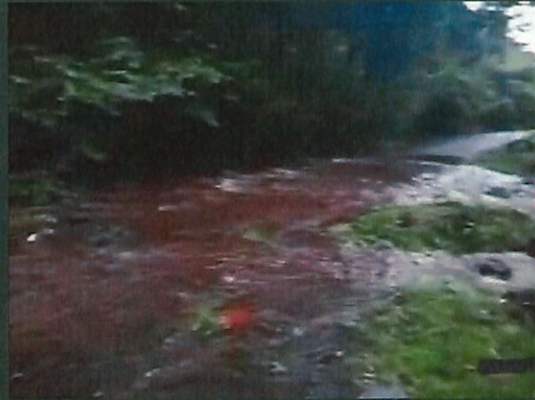
Paso alcantarillas caño Seco
