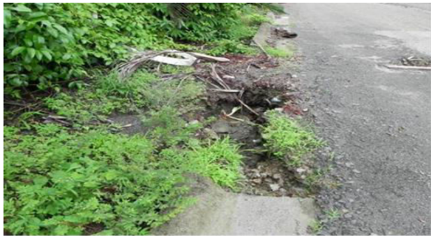
Detalle del tragante izquierdo totalmente colapsado por piedras, basura y materiales. Nótese que no tiene la caja del tragante construida ni la parte superior con la parrilla.
