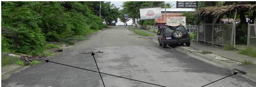
(Vista general del pozo de registro pluvial y los dos tragantes construidos en el 2010 donde terminan los 100 ml de sello asfáltico de la calle)
