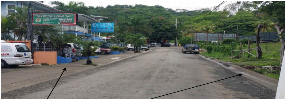
(Vista de los 100 ml de sello asfáltico de la calle con el entronque a calle principal. A la izquierda parte de las aceras realizadas por los propietarios de los negocios comerciales y a la derecha parte del cordón y caño realizado en el 2015)
