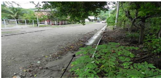
Vistas del tragante pluvial totalmente colapsado por piedra, arena y lastre y a la derecha ubicación del pozo pluvial en propiedad privada.
