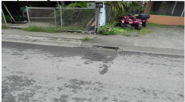
Vistas del tragante derecho totalmente colapsado por piedras y arena. Nótese que ambos tragantes no se encuentran terminados, no tienen construida la caja inferior y no poseen su parte superior con la respectiva parrilla. Ambos tragantes con parrilla fueron retirados de la ferretería y se desconoce su paradero.
