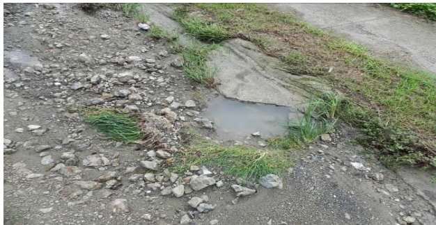
Vistas del tragante pluvial totalmente colapsado por piedra, arena y lastre y a la derecha ubicación del pozo pluvial en propiedad privada.
