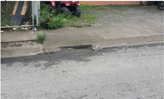
Vistas del tragante derecho totalmente colapsado por piedras y arena. Nótese que ambos tragantes no se encuentran terminados, no tienen construida la caja inferior y no poseen su parte superior con la respectiva parrilla. Ambos tragantes con parrilla fueron retirados de la ferretería y se desconoce su paradero.
