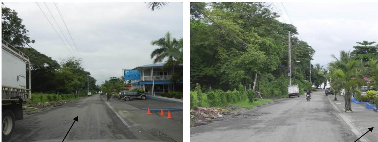
(Vistas generales de la calle en el sentido de la calle principal hacia la playa. En primer plano 100 ml de calle con un sello asfáltico realizado en enero 2017 y a la derecha 37 ml de cordón y caño y aceras realizadas por los propietarios de los negocios comerciales.)
