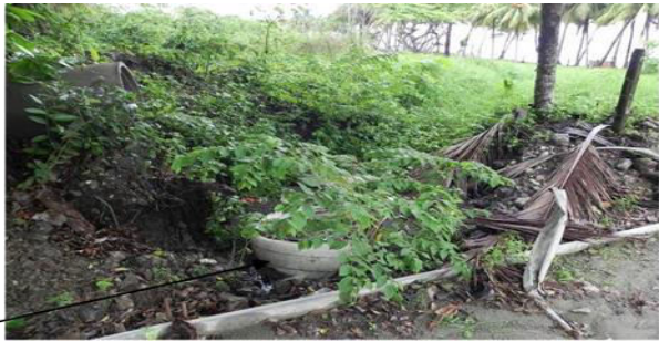
Vistas del tragante pluvial totalmente colapsado por piedra, arena y lastre y a la derecha ubicación del pozo pluvial en propiedad privada.
