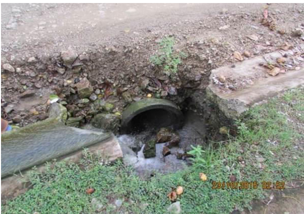
Vistas del tragante pluvial a la izquierda totalmente colapsado por piedra, arena y lastre y a la derecha como se encontraba el 23 de octubre de 2015.
