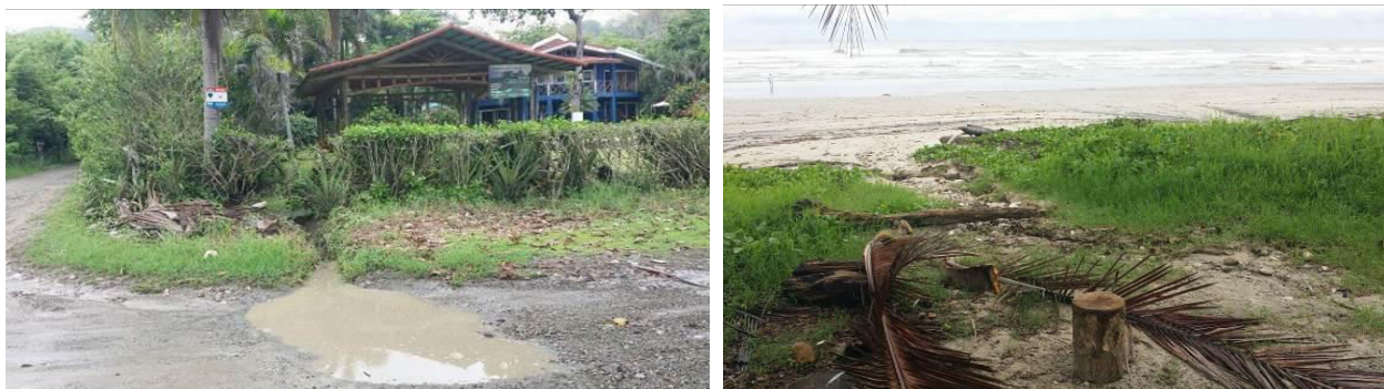
Vistas de la salida de aguas pluviales a la zona pública canalizadas por el Hotel Casa Azul.
