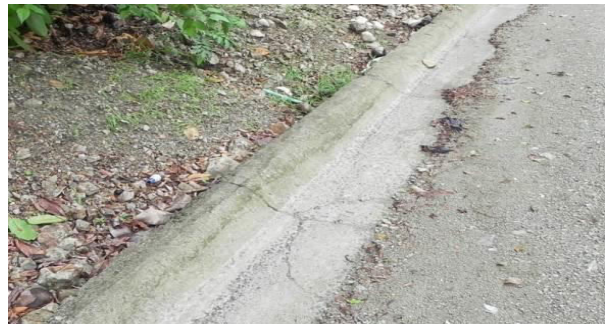
Vistas del tragante pluvial totalmente colapsado por piedra, arena y lastre y a la derecha ubicación del pozo pluvial en propiedad privada.
