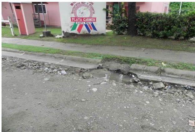
Vistas del tragante pluvial a la izquierda totalmente colapsado por piedra, arena y lastre y a la derecha como se encontraba el 23 de octubre de 2015.
