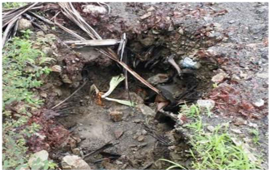
Detalle del tragante izquierdo totalmente colapsado por piedras, basura y materiales. Nótese que no tiene la caja del tragante construida ni la parte superior con la parrilla.
